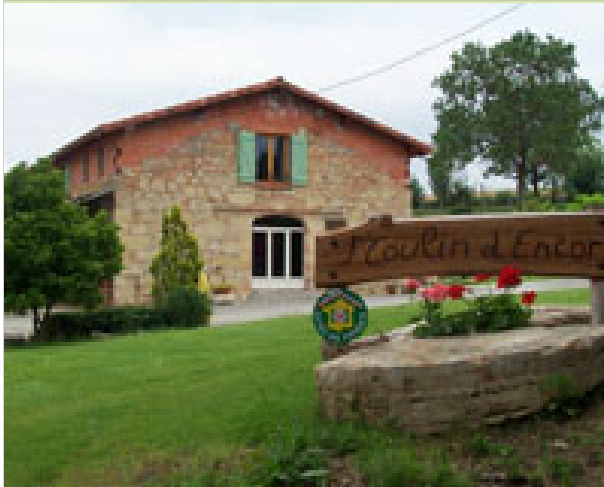
Au Moulin d'Encor 32130 SEYSSSES-SAVÈS
